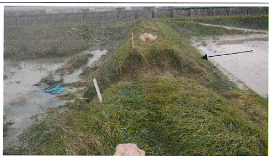
Figura 13: Danni all'argine in località la Barchetta (Campogalliano)
