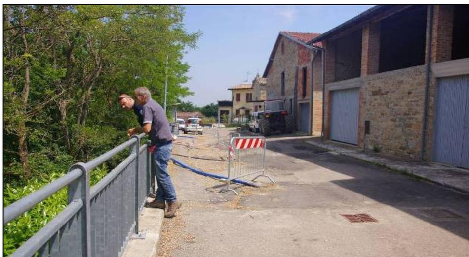
Fig. 9: situazione della frana di Pietta nella primavera 2013. Coinvolta la strada interna al paese, in seguito al cedimento parziale del cordolo su pali a sostegno della strada.
