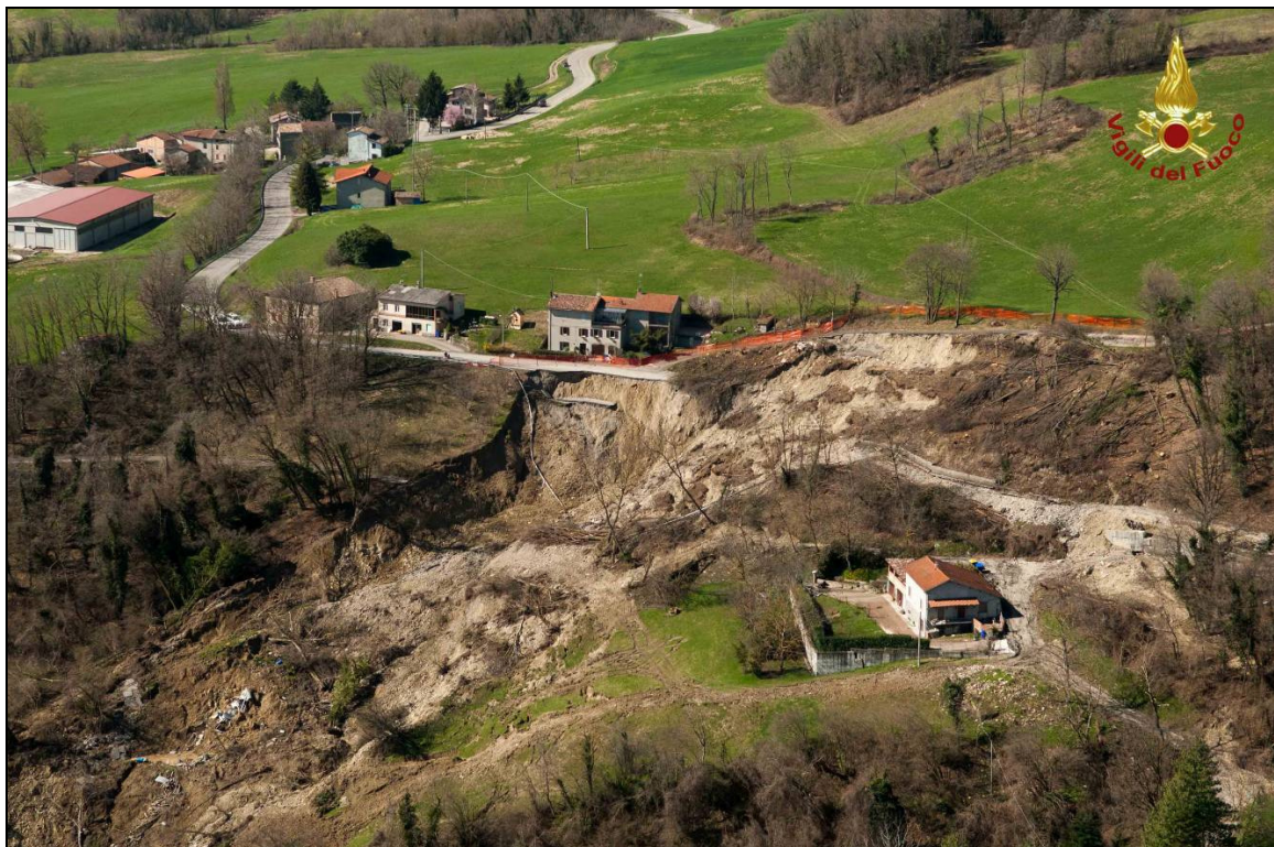
Fig. 4: Panoramica della parte alta della Frana di Boschetto (foto del Centro Documentazione Video – Vigili del Fuoco di Bologna).
