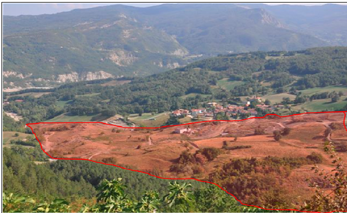
Fig. 2: Visione generale del piede della frana che lambisce il borgo di Sauna.
