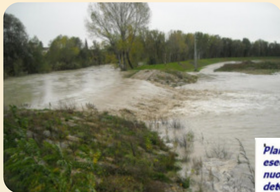
Cassa di espansione in funzione, Cà Bianchi, sul Savio a Cesena
