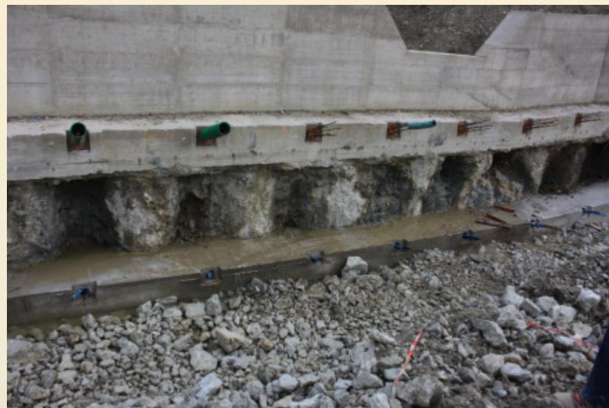
INTERVENTI NEL FOSSO CAMPONE
