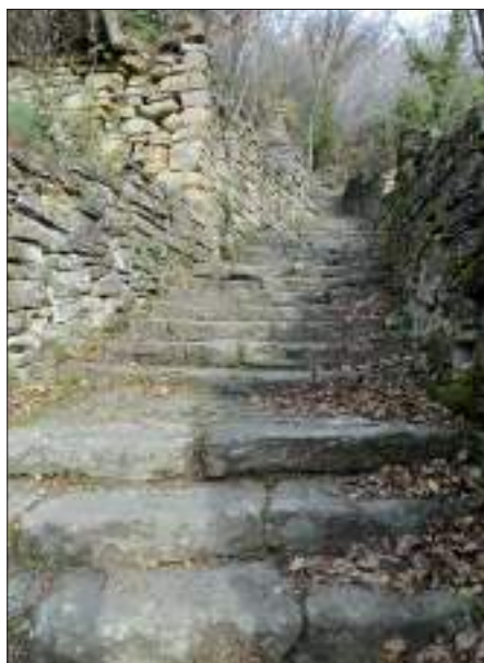
Figura 2. Costone carsico, paese di Prosecco; i terrazzamenti e le scalinate di collegamento tra la sommità del crinale e il tratto costiero presso Miramare, sono stati realizzati con la pietra arenaria locale posata a secco (foto Carlo Nicotra)
