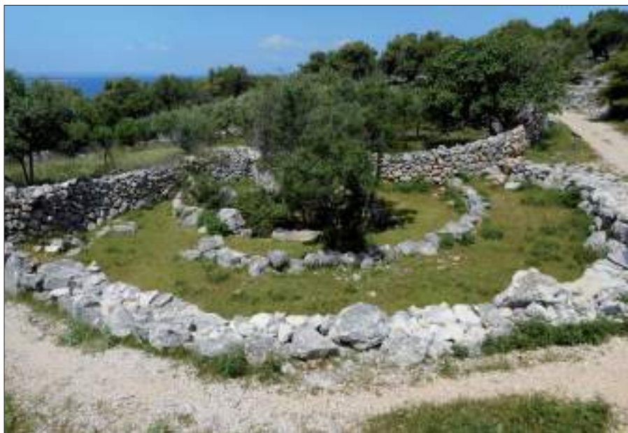
Figura 9. Dalmazia isola di Pago; la fonte perenne situata all'interno dell'area terrazzata degli uliveti di Lun viene delimitata dal contesto circostante da tre muri concentrici realizzati in pietra a secco (foto Carlo Nicotra)
