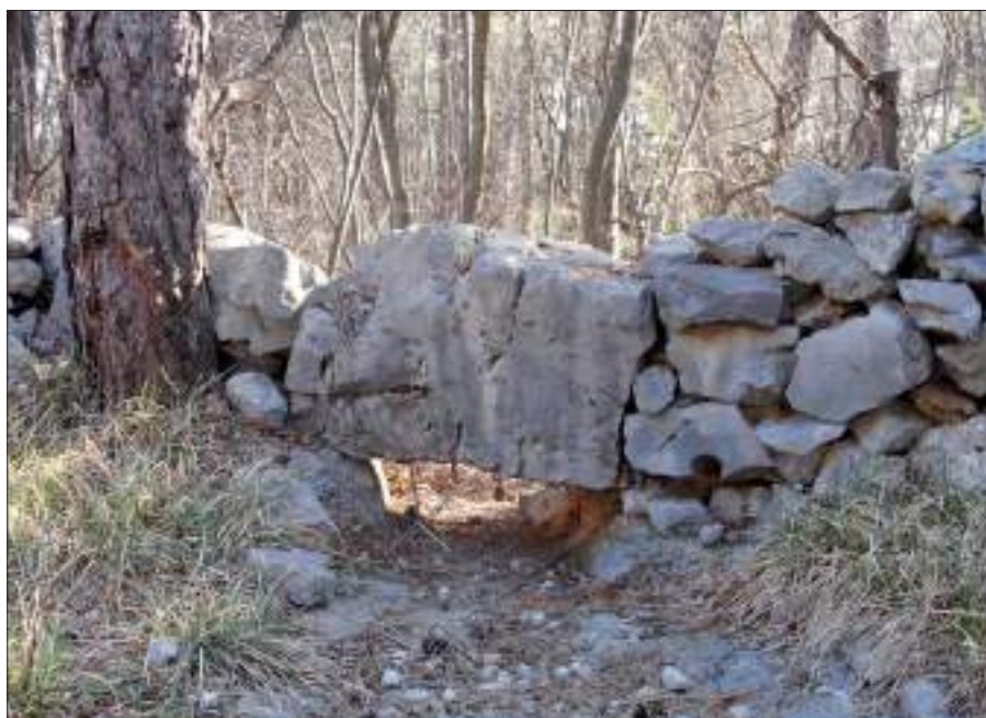
Figura 3. Carso di Monfalcone; varco di scarico delle acque meteoriche realizzato su un muretto di delimitazione in un'area rimboschita presso il monte Ermada (foto Carlo Nicotra)
