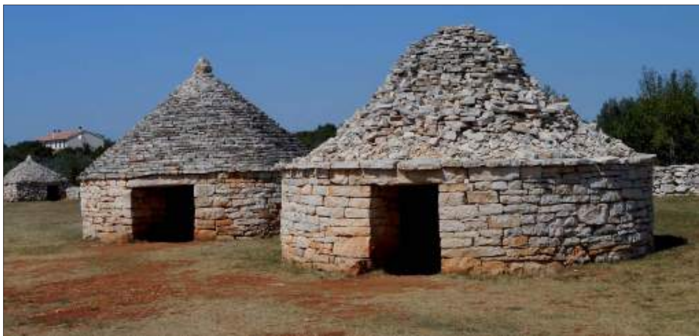
Figura 7. Istria, Dignano (Vodnjan); esemplari di casite ( kažuni ) realizzati a scopo didattico. I manufatti, ricostruiti all'interno del parco tematico sito in prossimità del centro abitato, illustrano tipologia e modalità costruttive di modelli ampiamente diffusi nella cultura e nel paesaggio nordpolesano (foto Carlo Nicotra)
