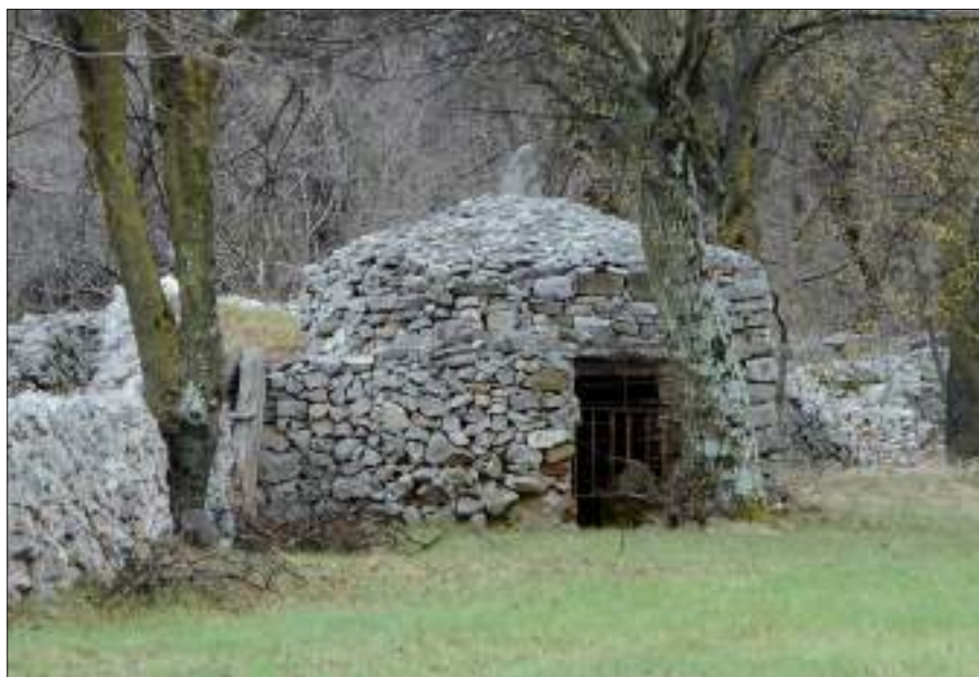
Figura 4. Carso triestino; casita realizzata in un fondo agricolo situato presso il paese di Trebiciano; la costruzione sfrutta l'elevato spessore del muro di delimitazione della proprietà (foto Carlo Nicotra)
