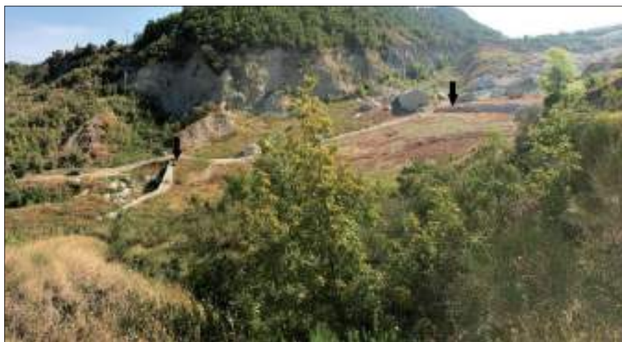
Figura 15. Foto panoramica delle due opere realizzate lungo l'asse vallivo del fosso Campone a seguito del crollo del 2014 per il contenimento della coltre detritica
