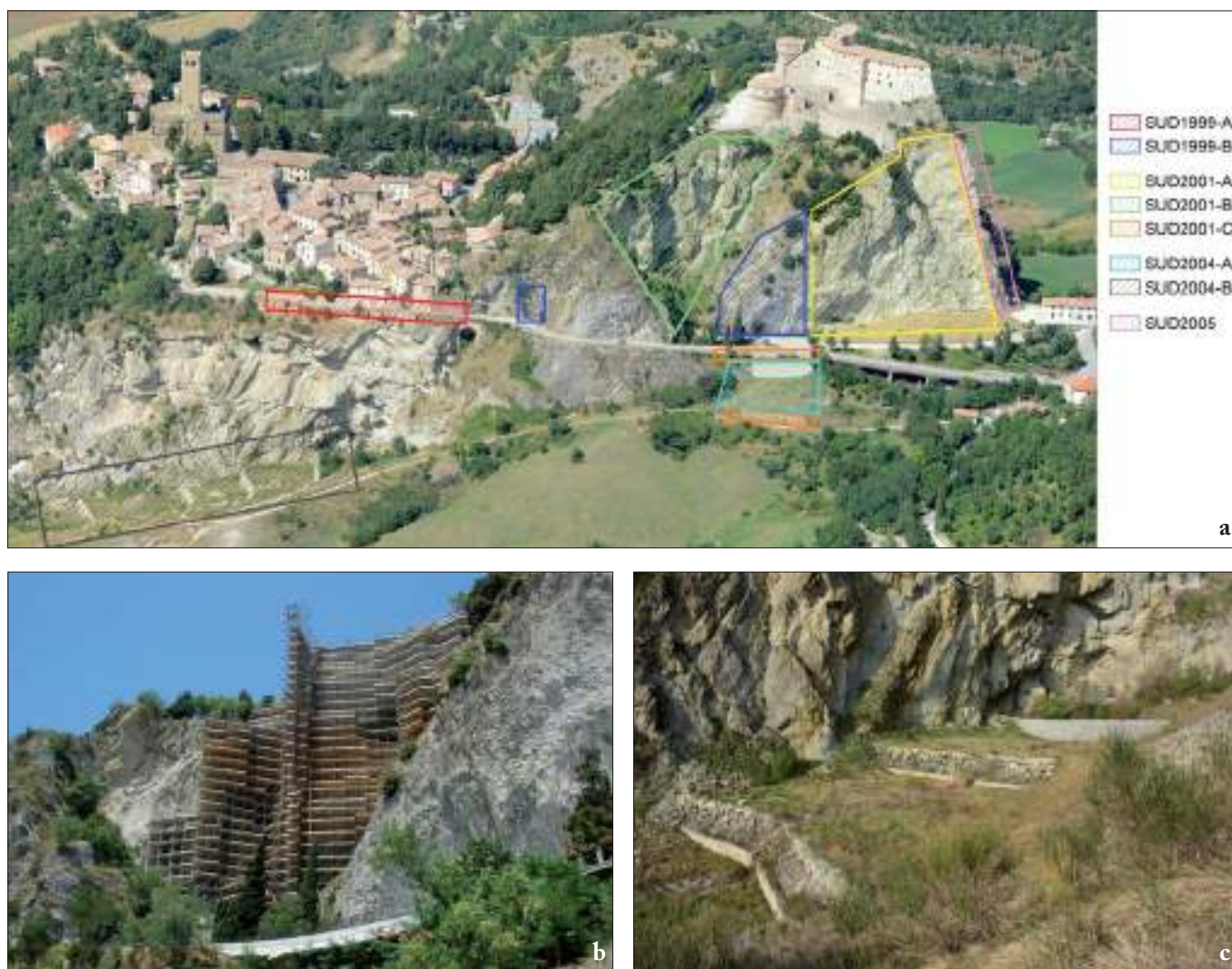
Figura 14. a) Quadro di sintesi degli interventi realizzati tra il 1999 e il 2005 lungo il versante sud della Rupe di San Leo. b) Uno degli interventi realizzati nella parete sud sotto la fortezza, avviati nel 2001 con impiego di estesi ponteggi. c) Gli interventi realizzati nel fosso Seripa alla fine degli anni 70 e nel 2004)
