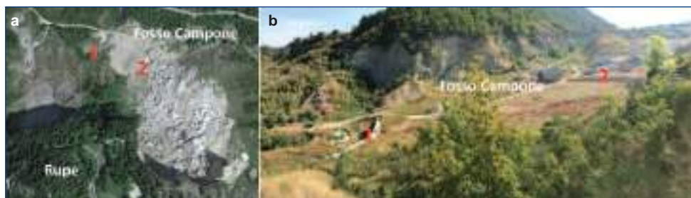
Figura 2. Ubicazione, in foto aerea (a) e in panoramica (b), delle opere strutturali realizzate per il contenimento della coltre detritica nel fosso Campone.
