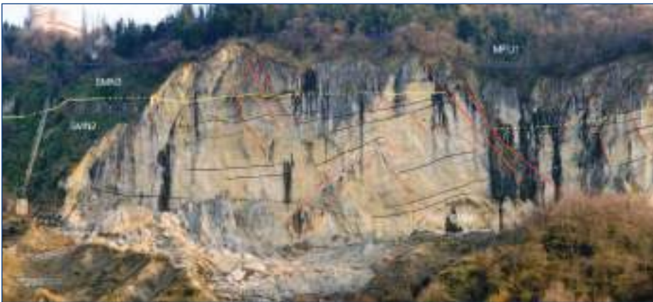
Figura 12. Parete NNW dopo il crollo del 2006. La stratificazione a banchi del membro SMN2 non è piano-parallela, s'immerge mediamente verso ENE e mostra variazioni di spessore che non si notavano nella parete NNE. Il contatto tra SMN2 e SMN3 è visibilmente discordante. Continua la gradinata di faglie distensive immergenti a WSW già vista nella parete NNE. Il membro MFU1 non affiora, anche perché la sommità della rupe è attualmente coperta dal bosco.
