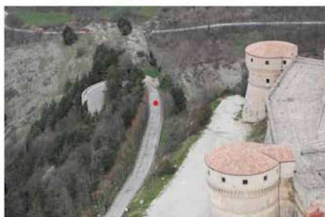
Fig. 19 - Ubicazione del sondaggio profondo nella zona del tornante lungo la via di accesso alla fortezza.
