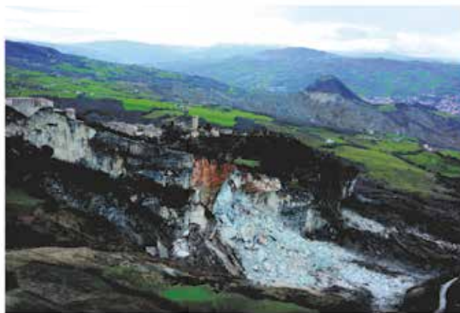
Fig. 5 - Foto panoramica da elicottero (vista da nord-est) che mostra la parete del crollo e l'accumulo detritico sottostante in tutto il suo sviluppo in corrispondenza del versante nord della rupe.
