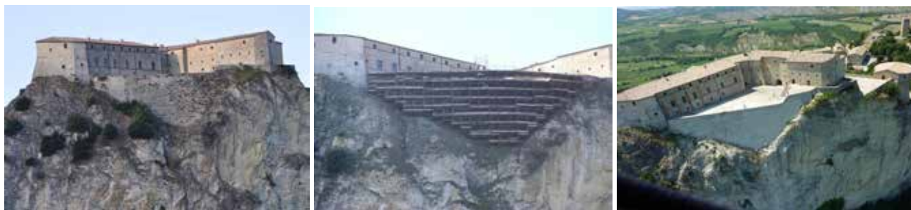
Fig. 14 – Immagini relative al muro di sostegno del terzo piazzale della fortezza. Le foto da sinistra verso destra rappresentano il muro prima, durante e dopo l'intervento.
