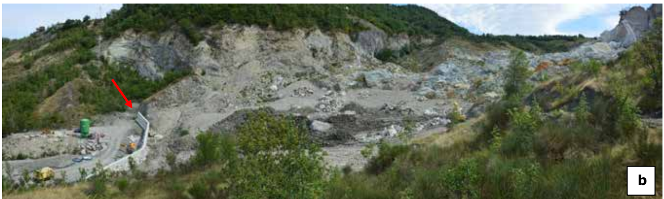
Fig. 20a - Veduta da satellite ( google earth ) dell'opera di contenimento realizzata e Fig. 20b - Foto panoramica. La paratia si colloca immediatamente a valle delle principali opere di sostegno realizzate in passato (tra 1978 e il 1988).
