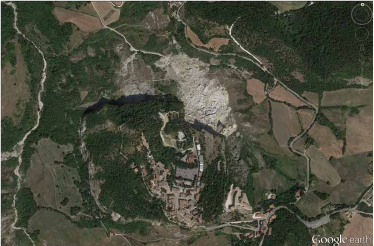
Fig. 2 - La placca rocciosa di San Leo su cui sorgono l'abitato (lato sud) e la fortezza (spigolo sud-est). In corrispondenza dello spigolo nordovest si apprezza l'ampio accumulo detritico determinato dal crollo del febbraio 2014. (Foto da Google Earth).
