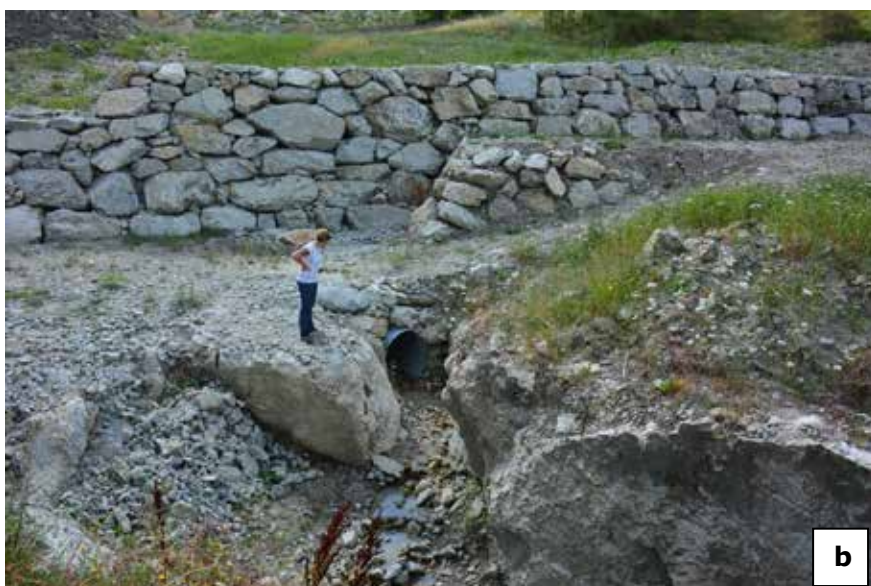
Fig. 22a - Trincea drenante profonda in fase di esecuzione; 22b – Convogliamento delle acque raccolte a monte dell'opera di contenimento e convogliate nel fosso Campone, a valle dell'opera.
