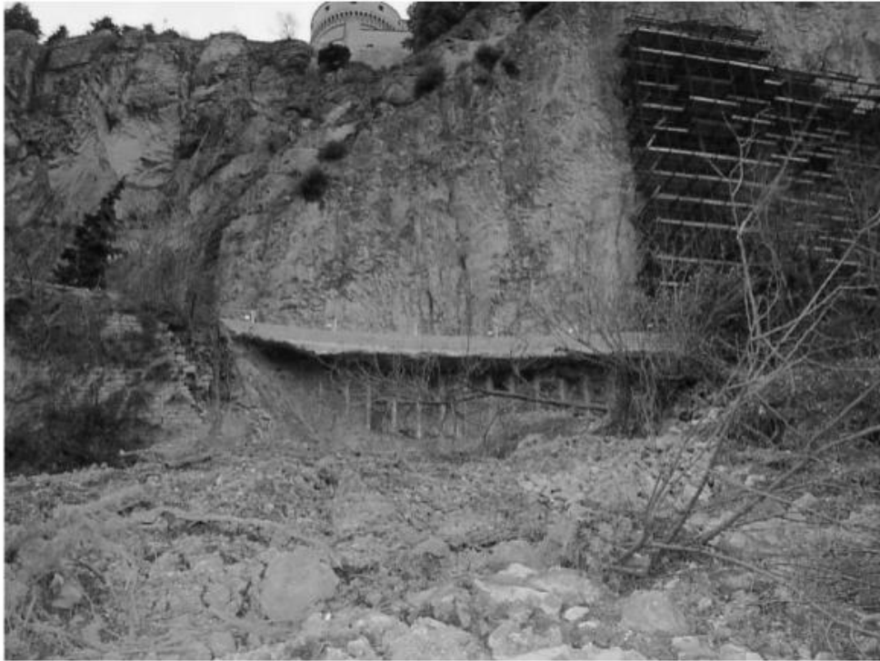
Fig. 8 – Interventi di consolidamento parete rocciosa lungo la parete sottostante la strada di accesso all’abitato di San Leo a seguito dell’evento franoso occorso nel 2004.
