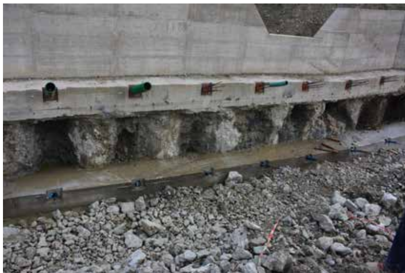
Fig. 21 – Paratia su pali con doppia trave e doppia fila di tiranti.
