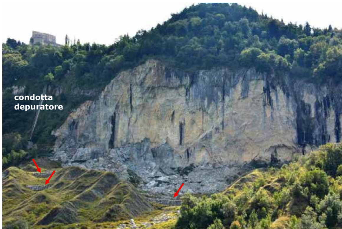
Fig. 11 Fronte del crollo del 2006, sono visibili in primo piano le briglie (frecce) in massi ciclopici a contenere il movimento della massa detritica, ammassata ai piedi della parete.
