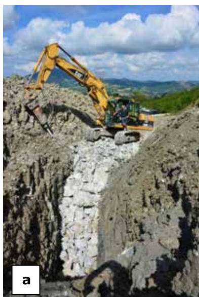
Fig. 22a - Trincea drenante profonda in fase di esecuzione; 22b – Convogliamento delle acque raccolte a monte dell'opera di contenimento e convogliate nel fosso Campone, a valle dell'opera.
