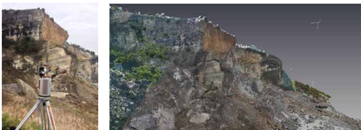
Fig. 16 – Il laser scanner impiegato per il rilievo del fronte di crollo con relativa immagine tridimensionale per la determinazione della nuova geometria della parete.
