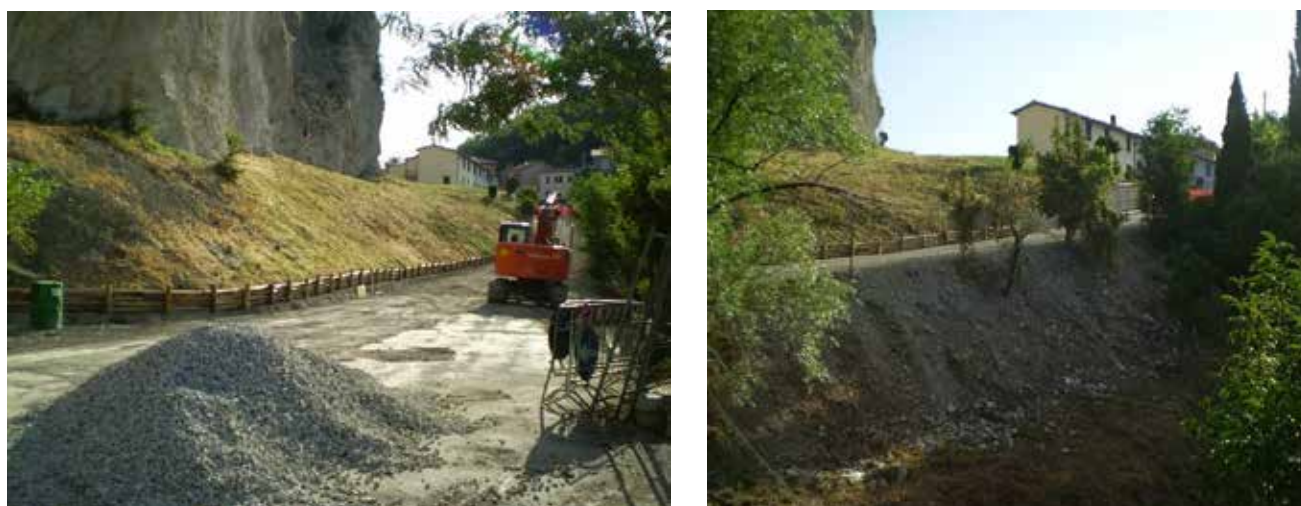
Fig. 13 – Immagini relative ai lavori eseguiti sul by-pass per garantire una viabilità alternativa al ponte per l'accesso al centro storico di san Leo.
