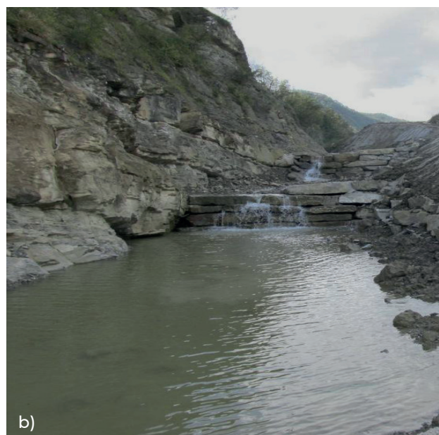
Figura 6. a) Immagine aerea della grande frana di Poggio baldi; b) corso del fiume Bidente dopo i lavori di sistemazione
