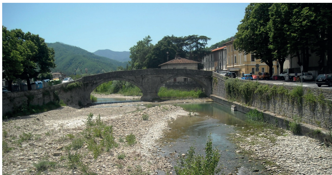
Figura 7. Fiume Savio San Piero in Bagno
