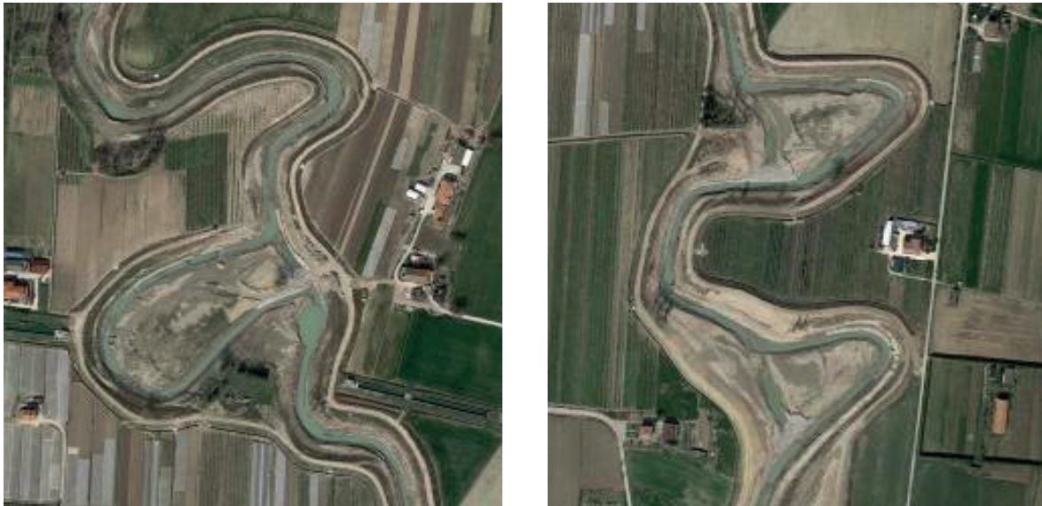
Figura 28. Lavori fiume Uso (Rimini-S.Mauro)
