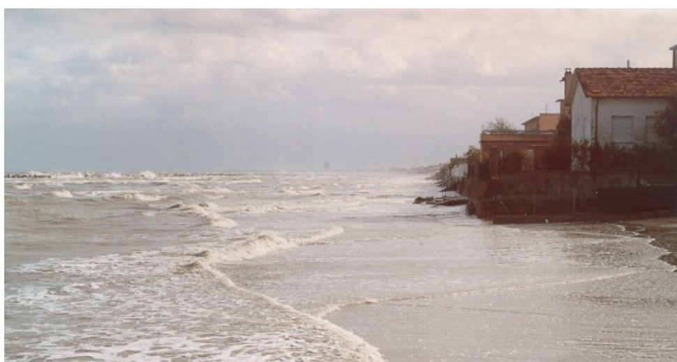
Figura 14. Spiaggia di Igea marina durante una mareggiata, prima dell'intervento di riqualificazione funzionale del sistema di difesa della costa
