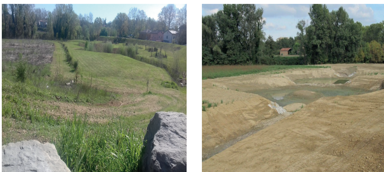
Figura 27. Lavori area fitodepurazione rio Ronco Vecchiazzano
