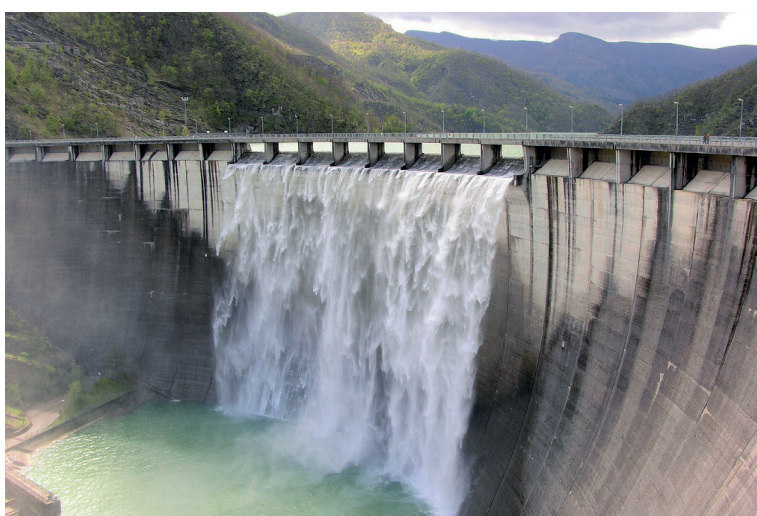
Figura 33. Diga di Ridracoli (Romagna Acque)
