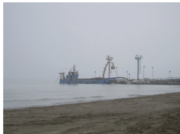
Figura 24. Novembre 2013: inaugurazione dell'impianto alla presenza dell'assessore Gazzolo e del sindaco Pironi. In basso: funzionamento dell'impianto. Scavo del materiale con la draga presso l'imboccatura del porto e refluento sulla spiaggia di Riccione sud ad una distanza di 3,3 km dal punto di prelievo
