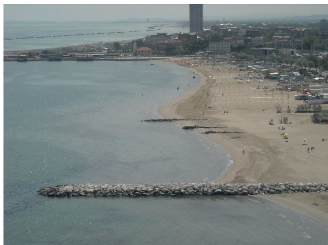
Figura 20. Cesenatico: spiaggia in località Ponente. Pennelli in roccia ("Pennellone" in primo piano) prima dei lavori
