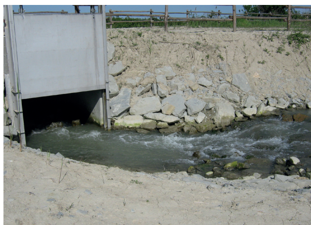
Foto 3. Scala di risalita per i pesci sul fiume Lamone a Bagnacavallo (Ra)
