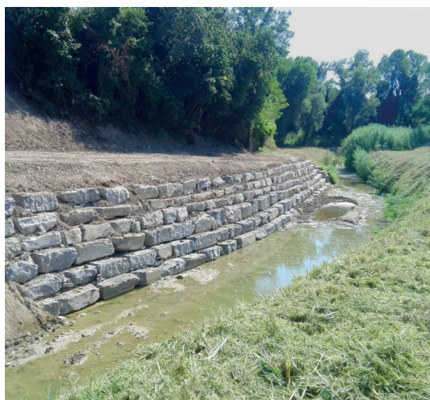
Figura 17. Tipologie di difese spondali e scale di risalita (Savio) in massi
