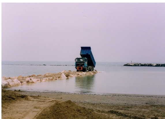
Figura 17. Varie lavorazioni di salpamento e ricarica scogliere durante l'intervento di riqualificazione funzionale delle opere di difesa della costa, in località Igea marina
