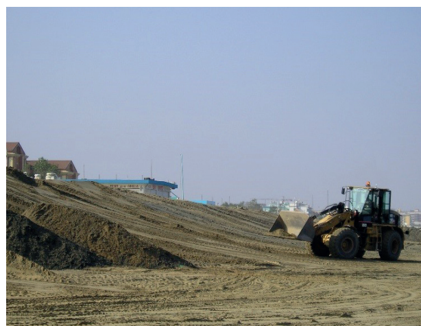
Figura 9. Lavori di realizzazione di argini (dune) invernali sulla spiaggia di Riccione
