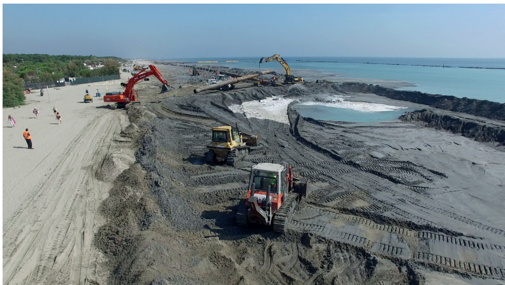
Figura 30. Progettone 3: lavori sulla spiaggia di Punta Marina
