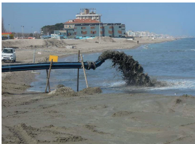
Figura 24. Novembre 2013: inaugurazione dell'impianto alla presenza dell'assessore Gazzolo e del sindaco Pironi. In basso: funzionamento dell'impianto. Scavo del materiale con la draga presso l'imboccatura del porto e refluento sulla spiaggia di Riccione sud ad una distanza di 3,3 km dal punto di prelievo
