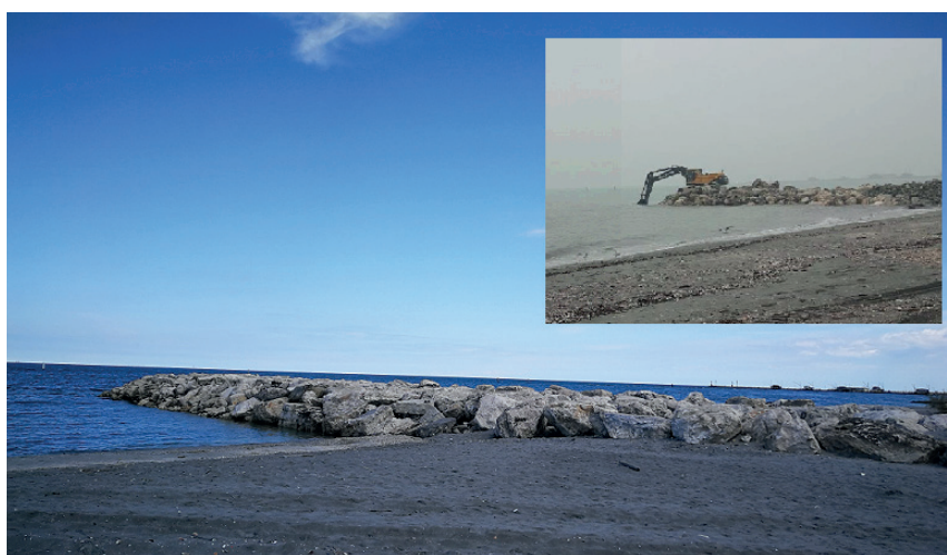
Figura 19. Salpamento scogli per accorciamento del pennellone
