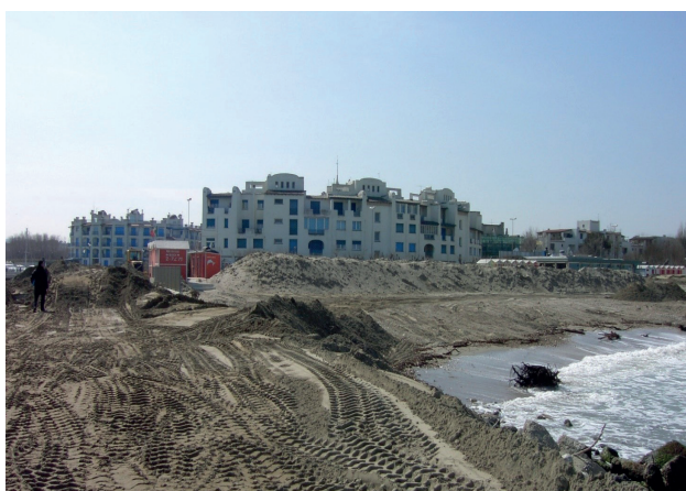
Figura 3. Argini (dune) invernali a difesa dalla ingressione marina, sulla spiaggia di Portoverde (Misano A.)
