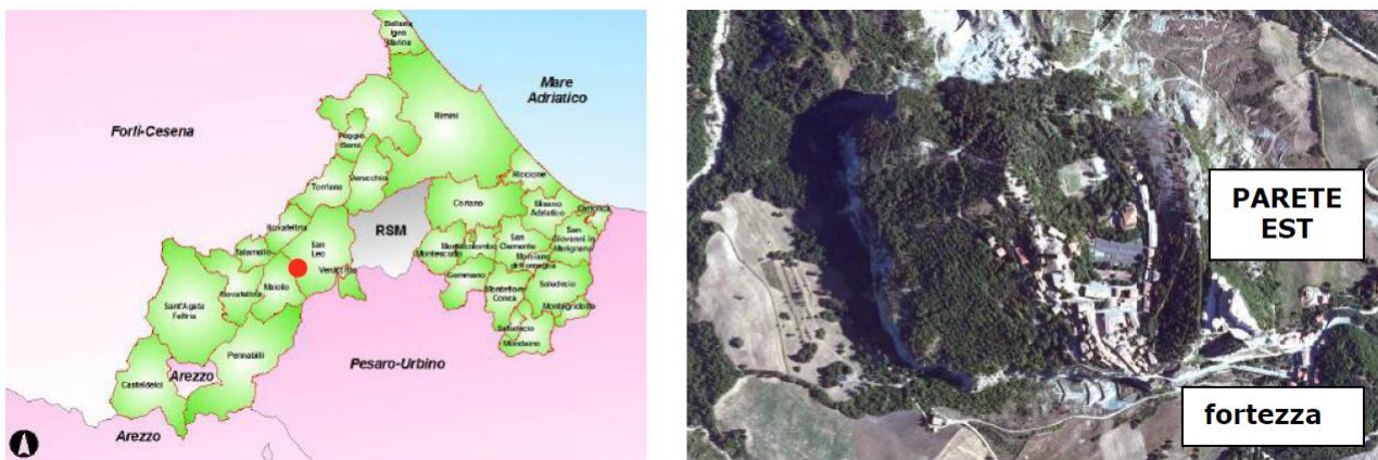
Figura 5 - Inquadramento corografico. Vista aerea della rupe di San Leo con in evidenza la parete est, oggetto dell'intervento di mitigazione del rischio idrogeologico
