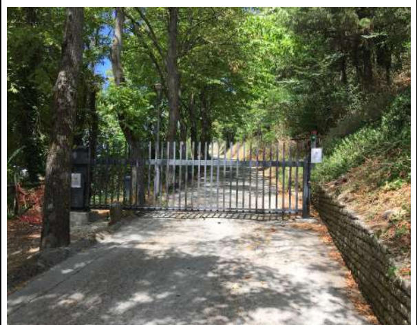
Strada di Accesso alla Rocca
