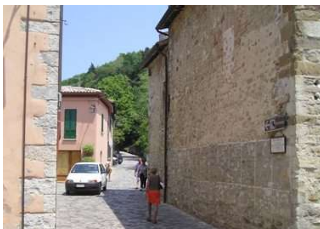
Accesso al cantiere bivio di via Montefeltro con
