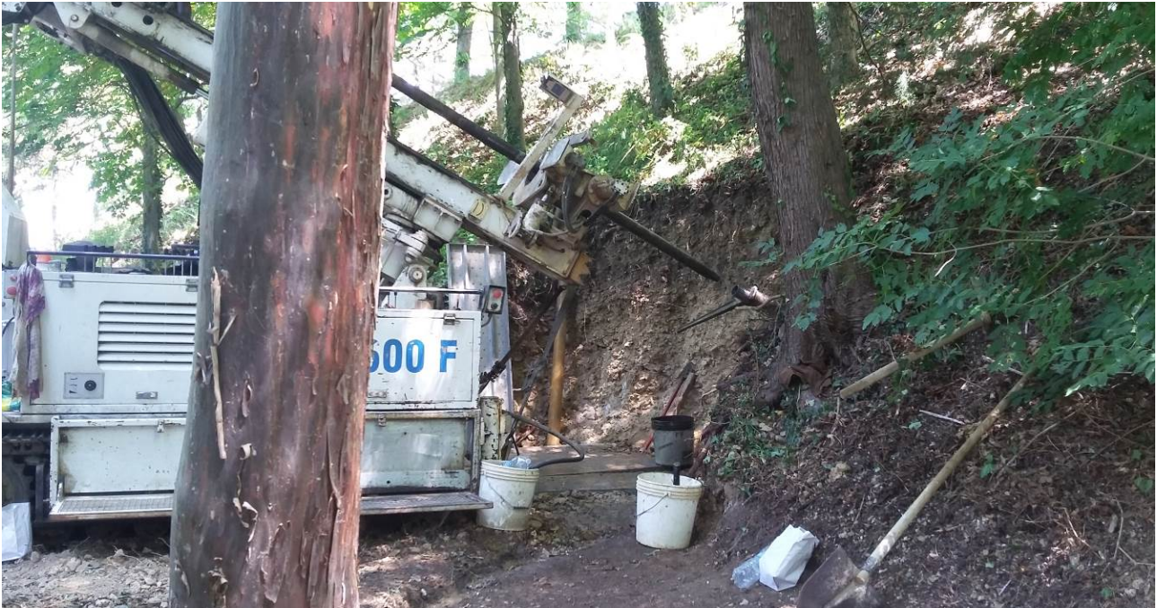
Figura 20 – Lungo il sentiero saranno ricavate delle piazzole di perforazione con piccoli interventi di scavo e riporto. Al termine dei lavori le piazzole saranno chiuse e il sentiero ripristinato. Le piante irrimediabilmente danneggiate o necessariamente abbattute saranno rimpiazzate con altri esemplari della stessa specie o di specie autoctone, coerenti con lo stato attuale del boschetto
