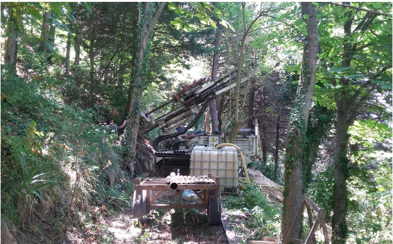
Figura 19 – Esempio di modalità di perforazione, realizzata (qui a scopo di indagine) sul sentiero pedonale che sarà impiegato per il trasporto dei mezzi e materiali nelle aree di perforazione per l'installazione ancoraggi "monte-valle" del settore A.
