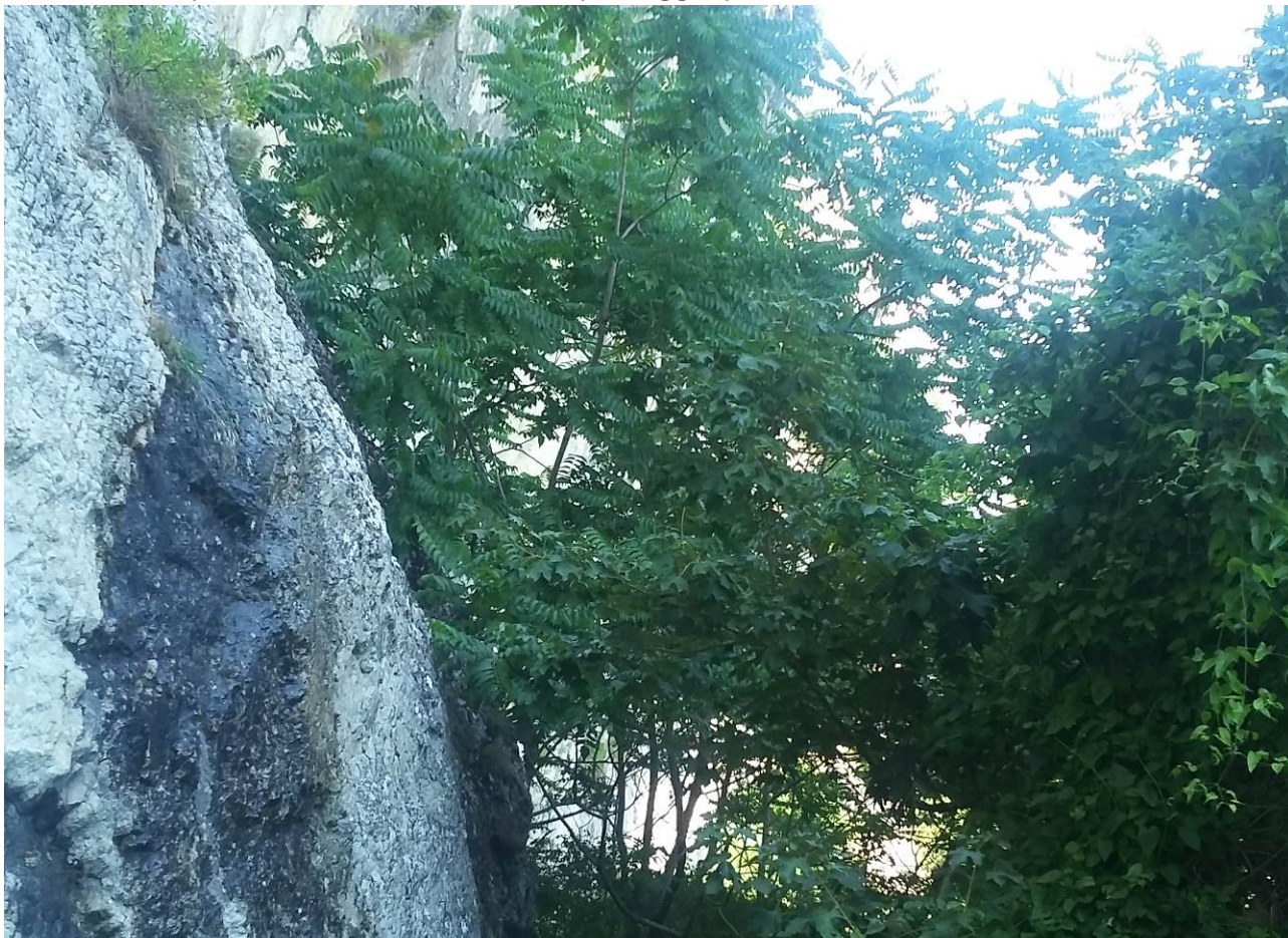
Figura 22 – Vegetazione arboreo-arbustiva ai piedi della rupe che sarà oggetto di taglio per la realizzazione del ponteggio provvisorio e la pista di accesso
