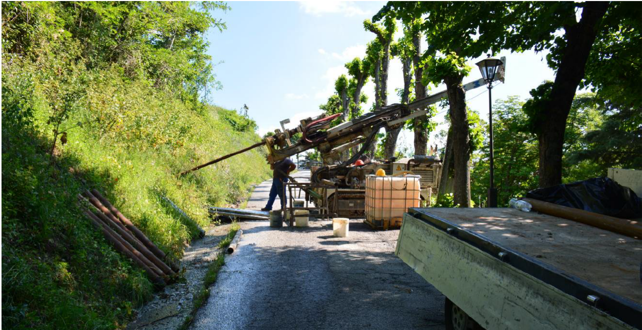
Figura 18 – Esempio di modalità di perforazione, realizzata (qui a scopo di indagine) sulla scarpata della strada di accesso alla fortezza di San Leo
