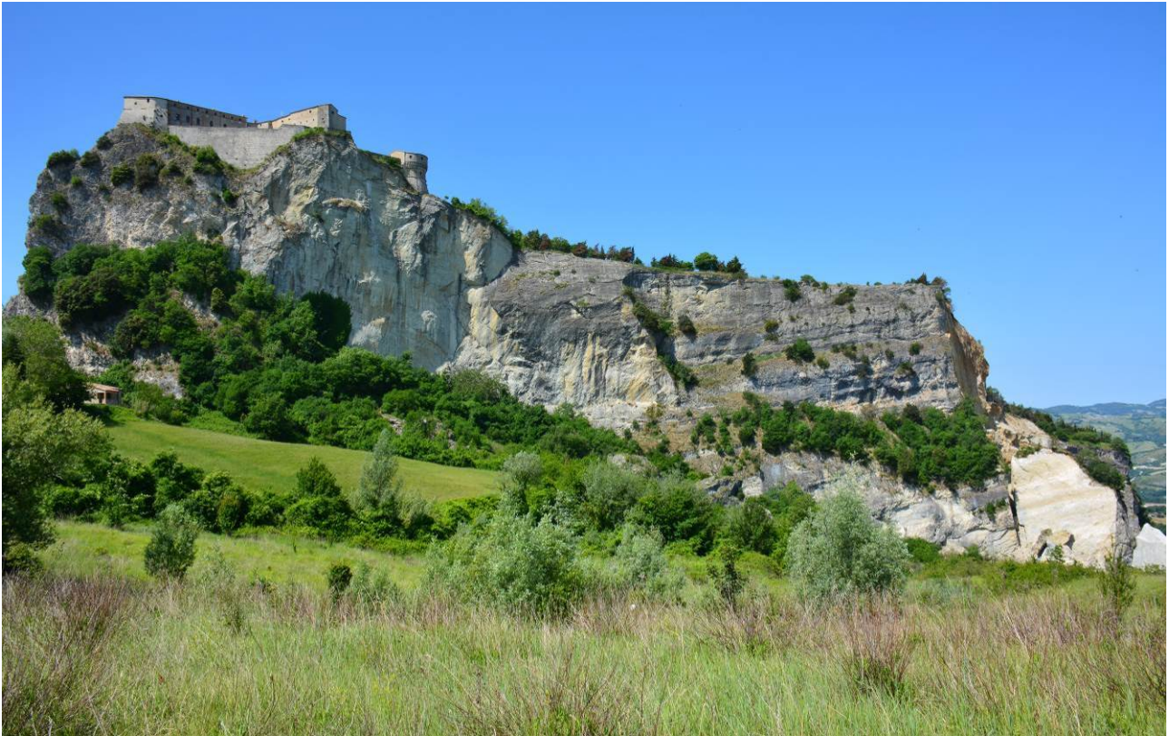
Figura 3 – Versante orientale della rupe di San Leo oggetto degli interventi di consolidamento
