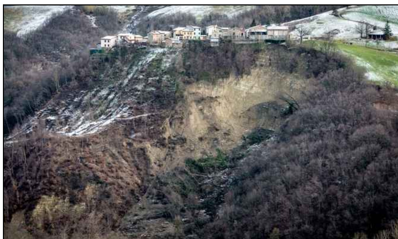
Fig. 7: vista della frana di Pietta dal versante opposto.
